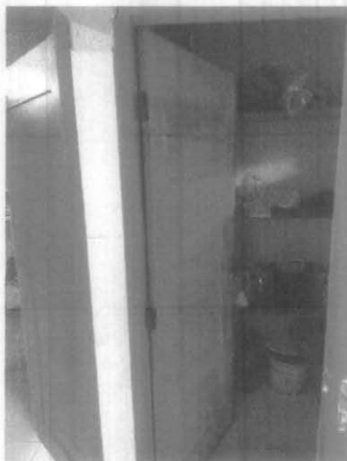
*Imagem 2 – Substituição de todas as portas da escola, por portas tipo mexicanas e prateleiras com bancada de granito com suporte de metalon.*
